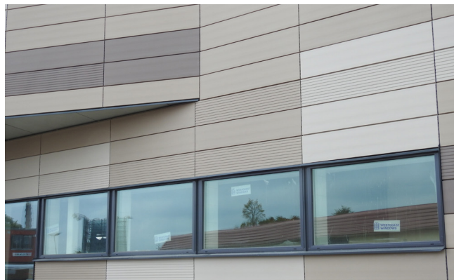
Fasadmönster med släta och "rillade" stenar
