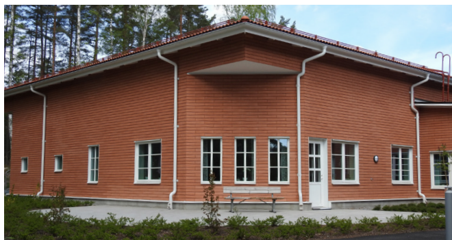
Norrköping, äldreboende. Tegelröd färg, stenformat 600x100 mm
