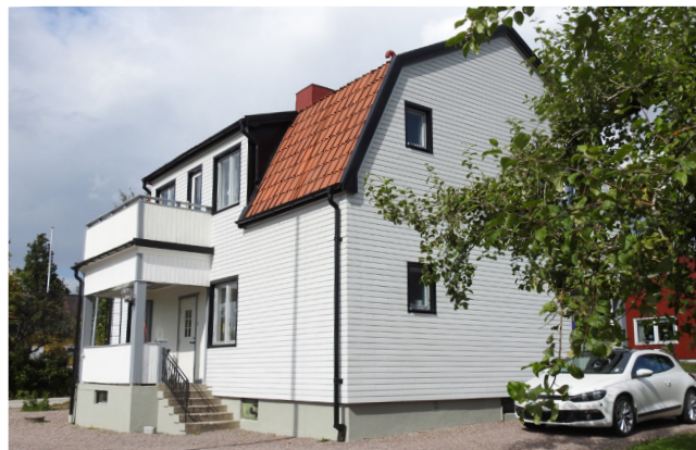
Kolbäck. Fasadförbättring med tilläggsisolering
