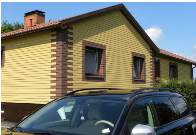
Köping. Fasadförbättring med tilläggsisolering
