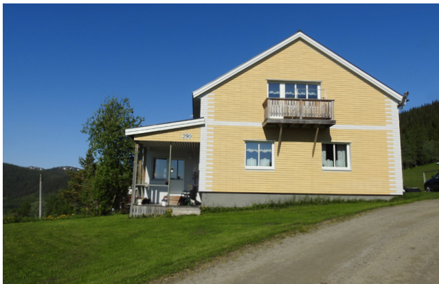
Jämtlandsfjällen. Fasadförbättring med tilläggsisolering
